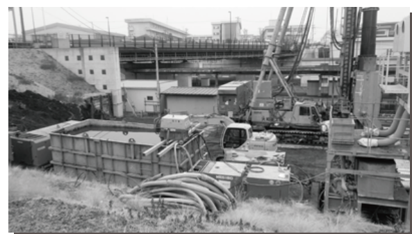
市施工で造成中の医療モール建設予定地 (2月15日撮影)
