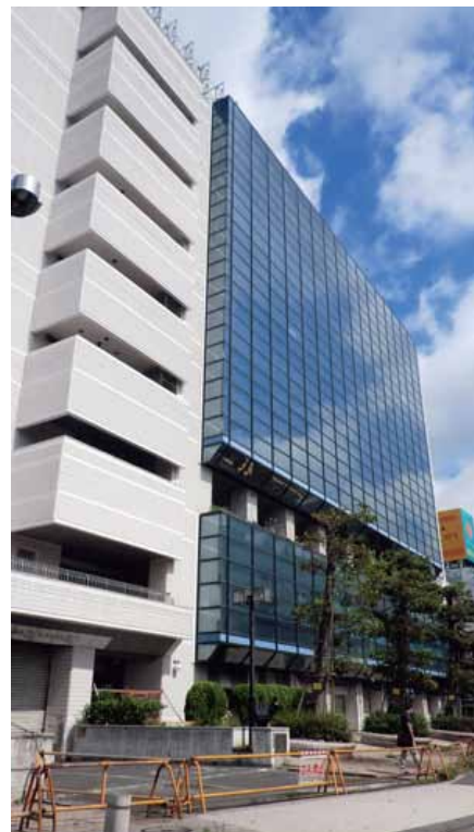
空きビルのままの「旧東急ビル」 (2012.7.3撮影)
